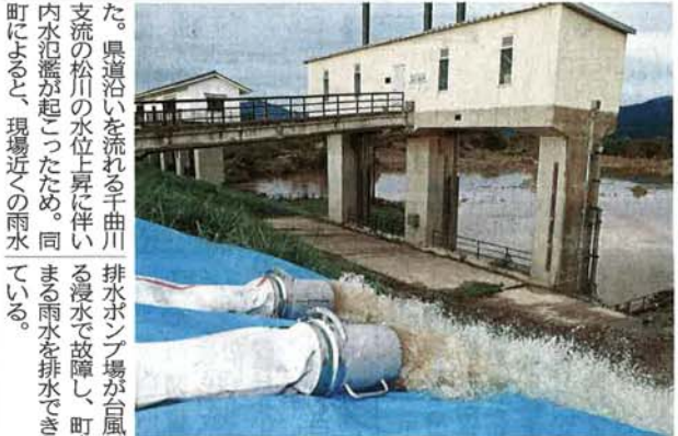
浅川と千曲川をつなぐ水門(中央)を閉め、ポンプ車などで浅川の水を千曲川に流した浅川排水機場。22日午後4時21分、小布施町吉島
