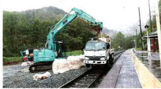
復旧現場へ運ぶ砂利の積み込み作業=25日午後1時21分、松原湖駅
