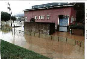
血川の決壊で浸水し、機能停止に陥った城山雨水排水ポンプ場。13日午前10時48分、飯山市
