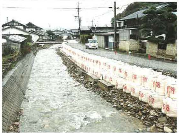
護岸が仮復旧し、車が仮設道路を通れるようになった佐久市の谷川沿い 29日
