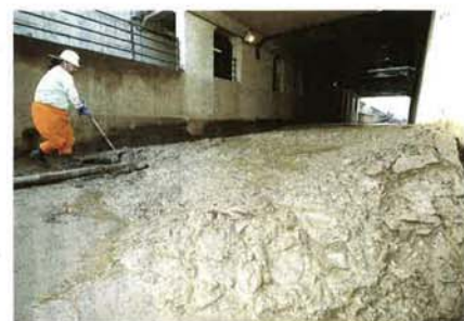
アンダーパスでは路上の高さにまでたまった泥をバキュームカーと重機で取り除く作業が行われ、作業員は「復旧のめどは立っていない」＝30日午前8時43分、長野市篠ノ井塩崎
