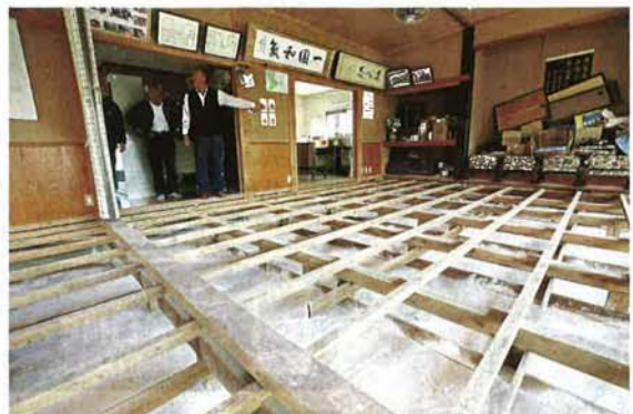
床板をはがし、消毒の消石灰で真っ白になった作見公民館。11月20日頃には乾燥を終え床板を張りたいという＝30日午前11時20分、長野市篠ノ井ツ柳
