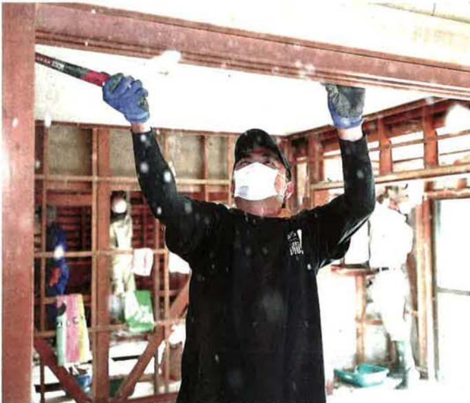
岡山県倉敷市真備町から駆け付け、浸水被害を受けた住宅の壁を削がす小田さん(2日午前11時44分、長野市赤沼/中村桂吾撮影)
