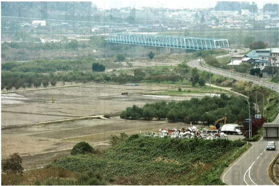
被害が大きかった上今井橋(奥)周辺。手前の待避所では災害ごみの片付けが行われる一方、河川敷の泥は泥に覆われたままだった。6日午後0時25分、中野市立弁
