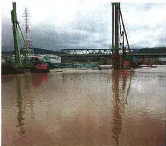
浸水した新ごみ焼却施設の建設 工事現場＝10月13日、千曲市屋 代中島（長野広域連合提供）
