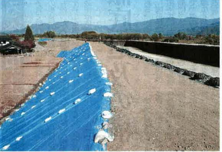
堤防決壊から1カ月たった千曲川左岸。同じ位置に造成された仮堤防(中央)横の住宅地側(左側)は現在、整地されている＝13日午後1時19分、長野市穂保
