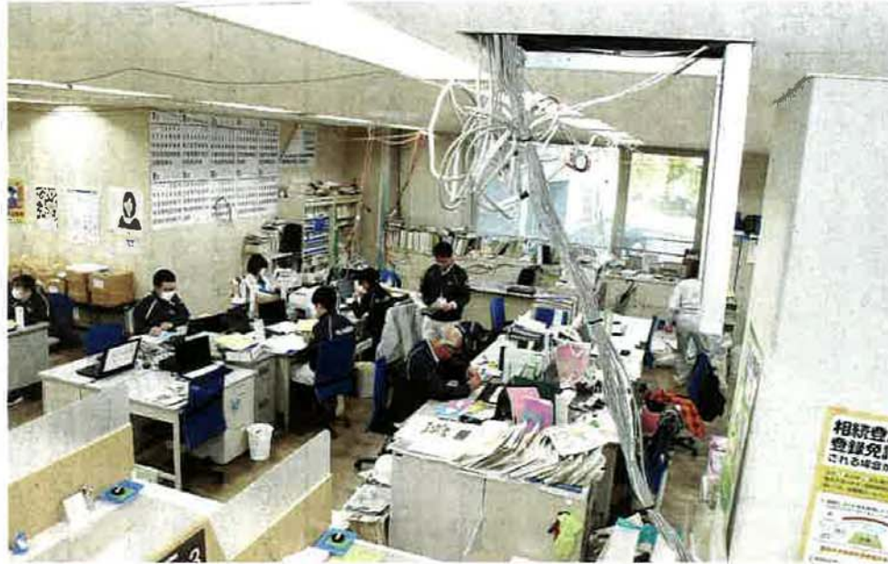
1階部分が水没して床下の電源や電話回線が使えなくなったため、今なお天井から配線して、職務に当たる職員ら＝14日、飯山市役所
