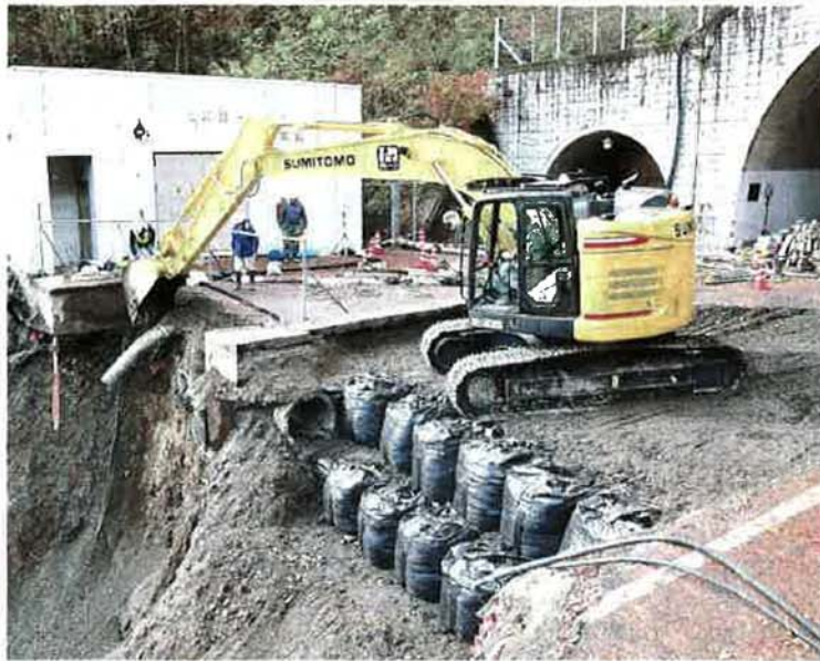
権兵衛トンネル(右)の出入り口付近で行われた崩落箇所の撤去作業=14日、飯田国道事務所提供
