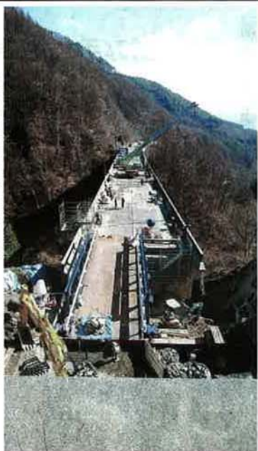
仮橋の架設工事が進む国道361号の崩落箇所 13日、南箕輪村(飯田国道事務所提供)
